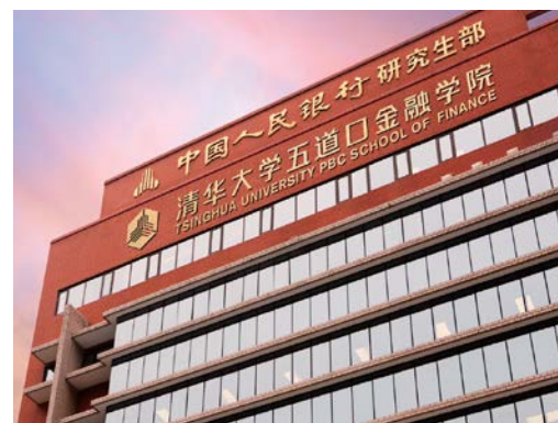
Ansicht des zentralen Lehrgebäudes der PBC School of Finance, Tsinghua Universität, Peking (Quelle: http://eng.pbcsf.tsinghua.edu.cn )
